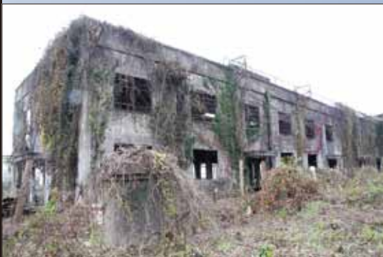
平成 24 年 3 月 川南造船所部品工場跡建物解体
