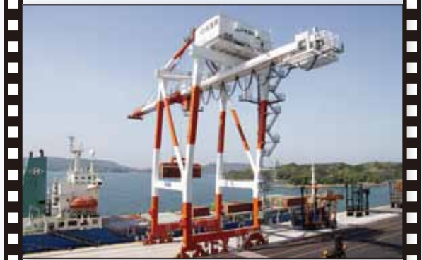
平成 25 年 4 月 伊万里港七ツ島国際コンテナターミナルの拡張工事完了・供用開始
