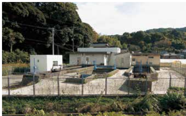
取水ポンプ場／ここにあるポンプで浄水場まで汲み上げます。
