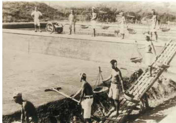
砂の入れかえ作業
