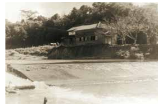
伊万里川取水口とポンプ室
