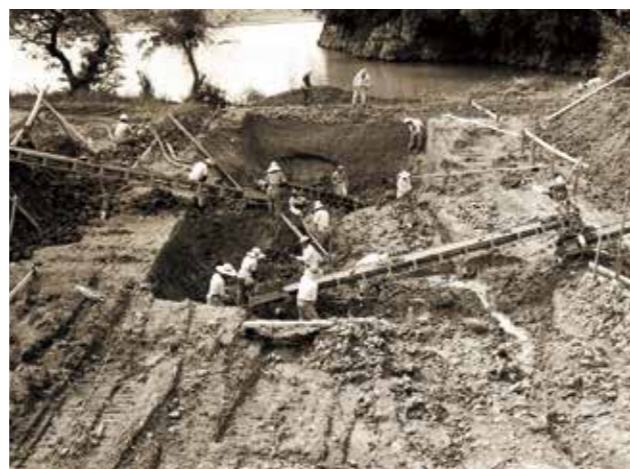
沈砂池掘削中
