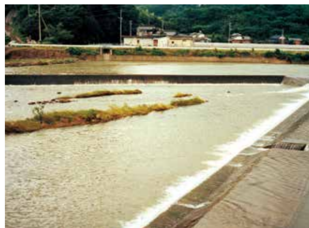
有田川取水施設 (又川堰)
