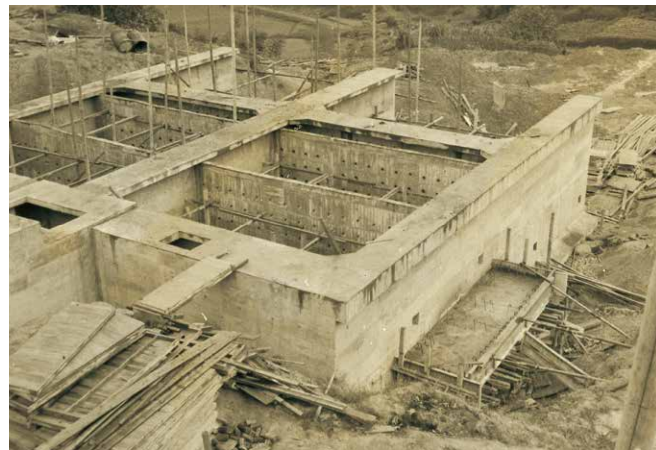
建設中の浄水施設
