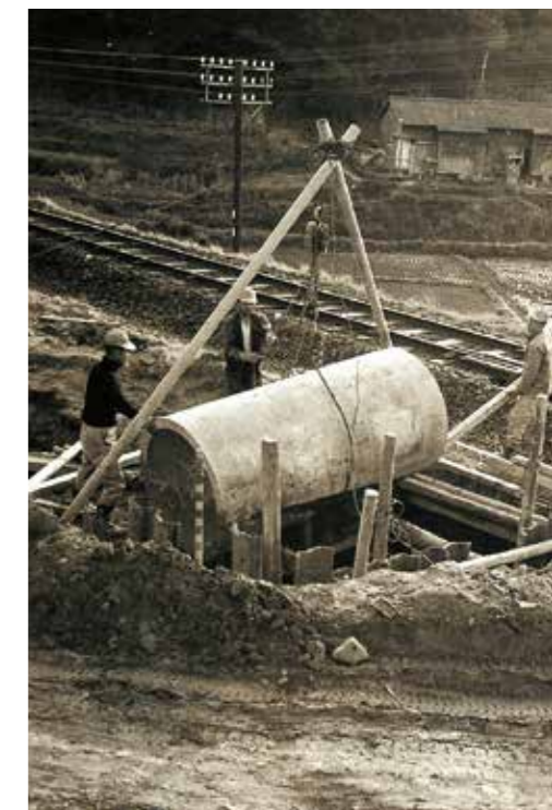
鞘管を使い鉄道敷地を横断
