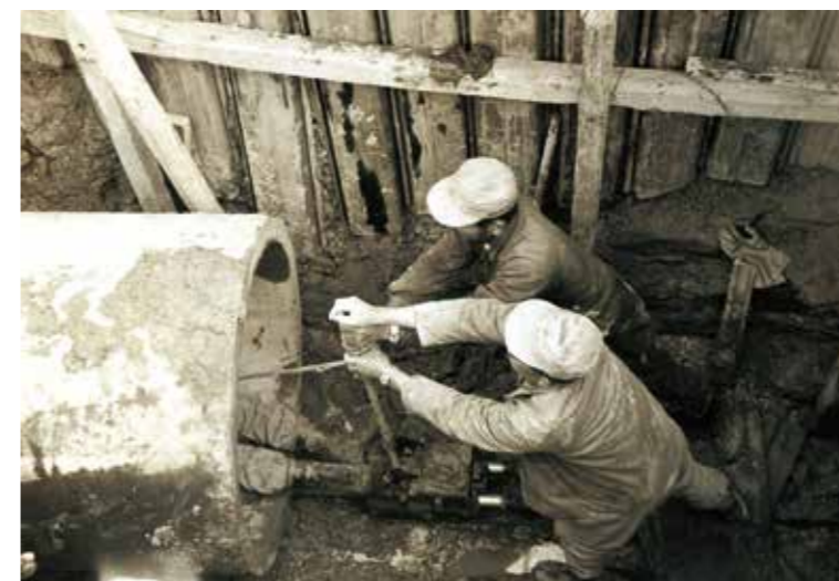
鞘管 (水道管を保護する外装管) で少しずつ地中を掘る工法
