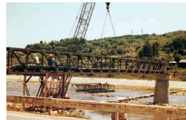
導水管(第4水管橋)の設置工事風景(1期工事分)
