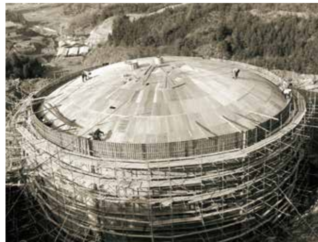
容量4,730m 3 の2号配水池建設状況
