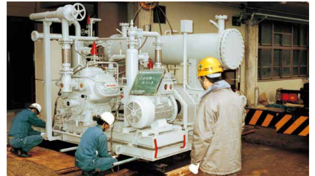
排水処理施設・機械据付
