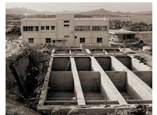
建設中の浄水施設(1期工事分)
