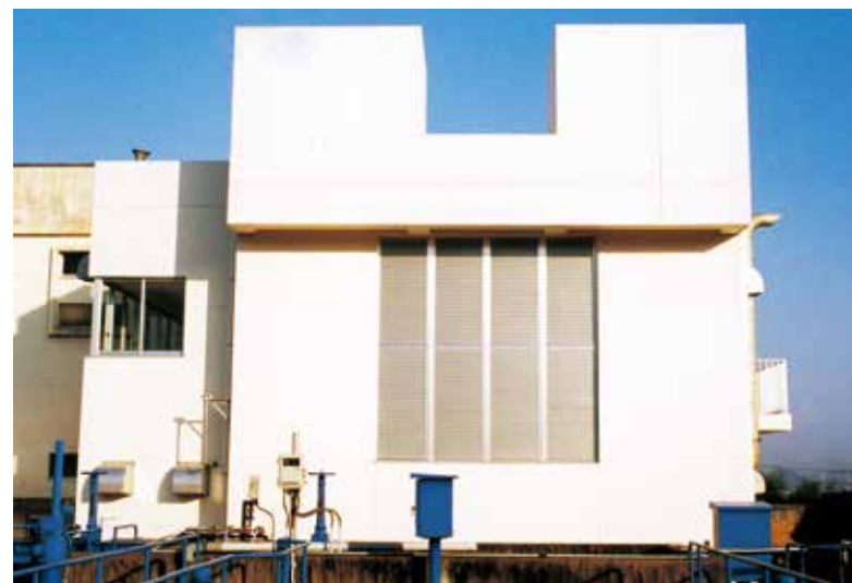
受変電設備が入っている増築部分
