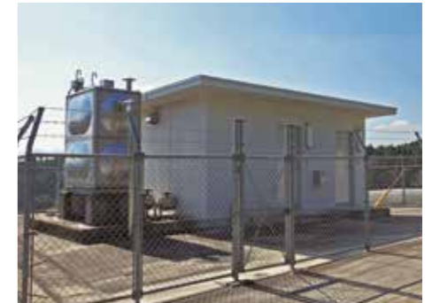
岳坂送水ポンプ場
