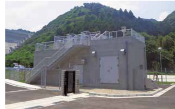
生物接触ろ過棟
