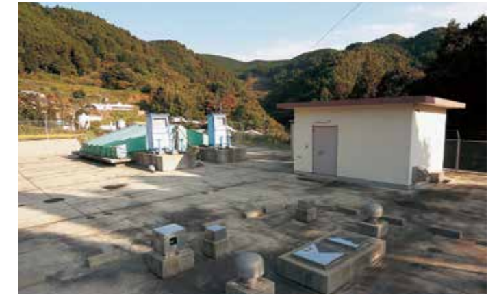
川内野簡易水道浄水場
