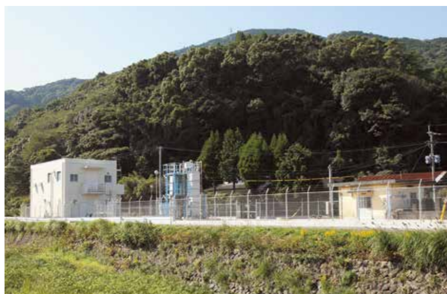
浦ノ崎浄水場
