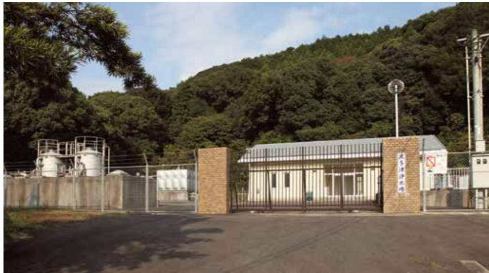
波多津浄水場
