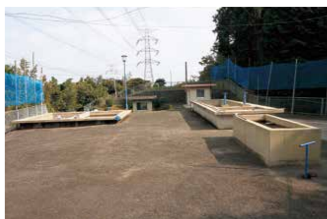
峰簡易水道浄水場
