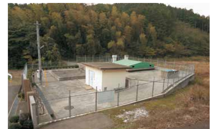
木場簡易水道浄水場
