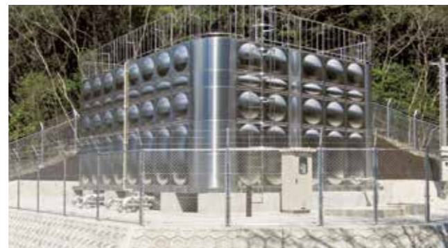
波多津2系配水池
