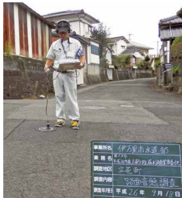
委託業者による漏水調査
