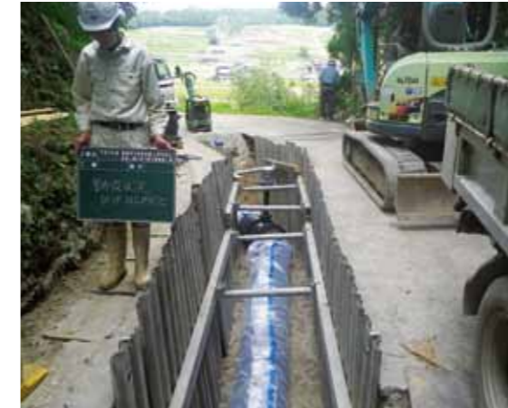
平成26年度 導水管移設工事 NS形ダクタイル鋳鉄管φ450 布設状況
