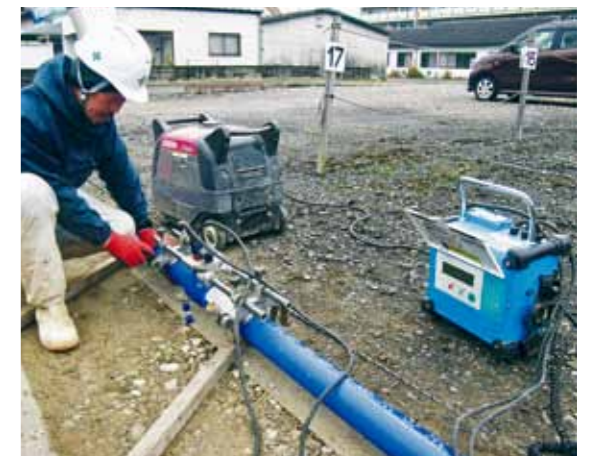
平成25年度 古賀線配水管新設工事 配水管ポリエチレン管φ150布設状況と融着接合の様子
