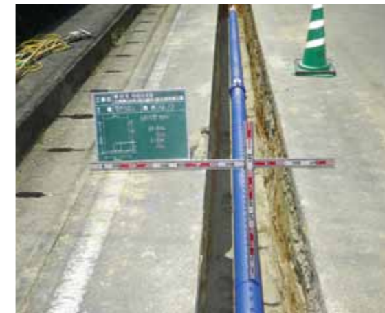
平成25年度 古賀線配水管新設工事 配水管ポリエチレン管φ150布設状況と融着接合の様子
