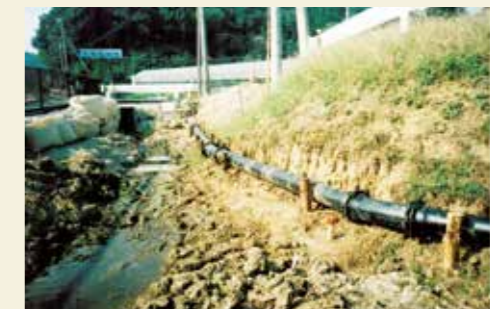
国道202号地すべりによる配水管の仮設復旧工事
