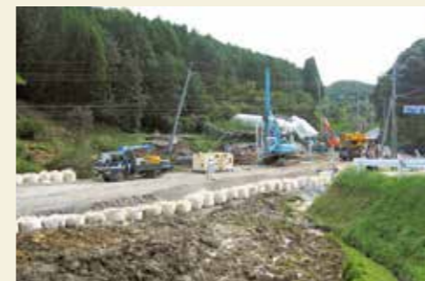
国道202号地すべりによる配水管の仮設復旧工事
