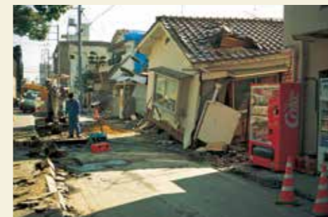
配水管の復旧工事
