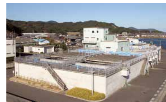
久原浄水場沈殿池
