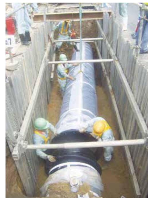
導水管布設状況
