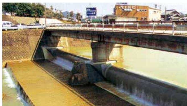
六仙寺のラバーダム (取水堰)
