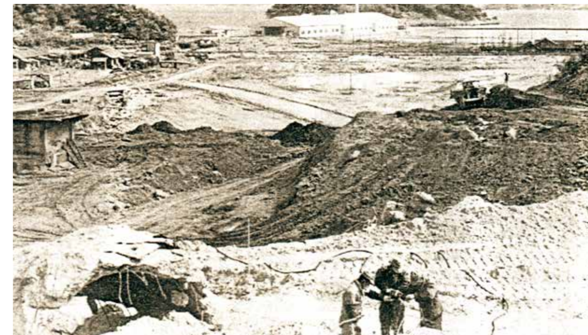
工業団地の造成すむ山代町久原地区A団地
