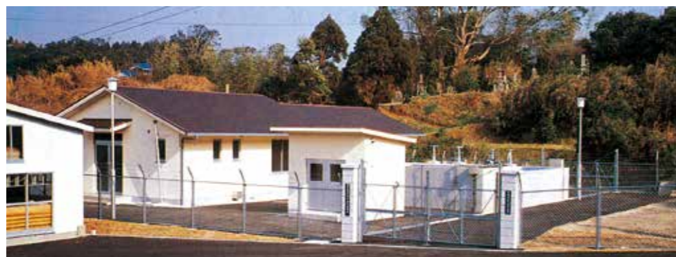
第2工業用水道浄水場
