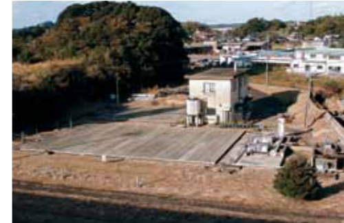
長浜第1浄水場
