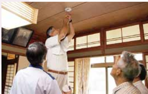
ボランティアによる住宅用火災警報器を設置
