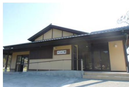
↑入口に段差解消のためのスロープを取り付けるなど利用しやすい施設として整備
