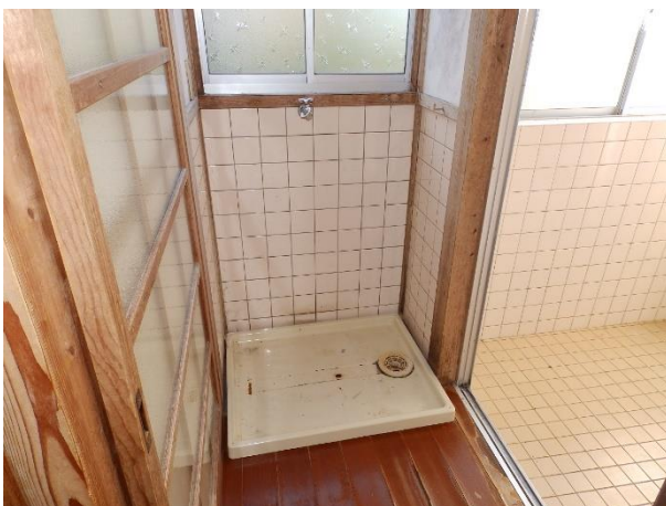
【洗濯機置き場】
