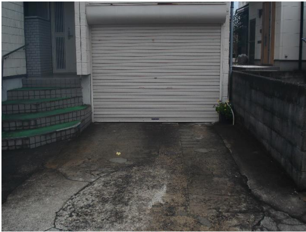
【倉庫・駐車場】
