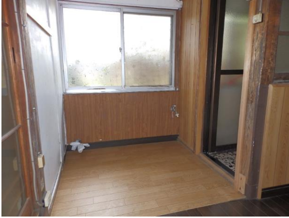
【洗濯機置き場】
