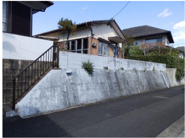
【前面道路からの外観】
