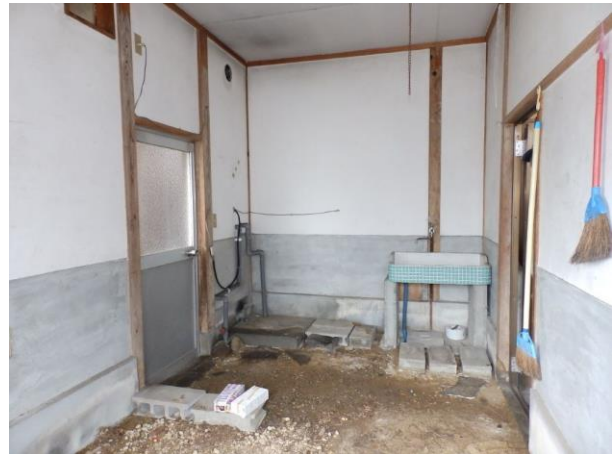
【駐車スペース横倉庫内部】
