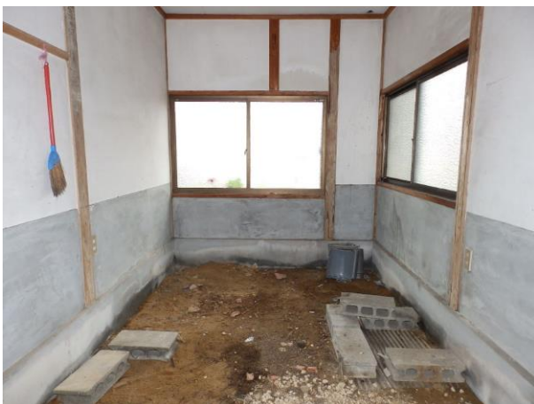
【駐車スペース横倉庫内部】
