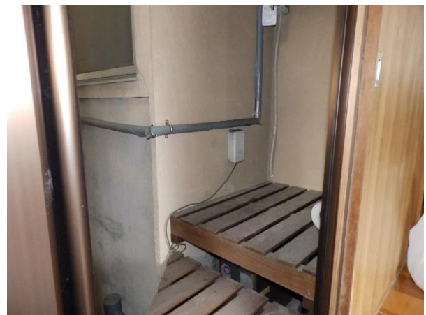
【洗濯機置き場】
