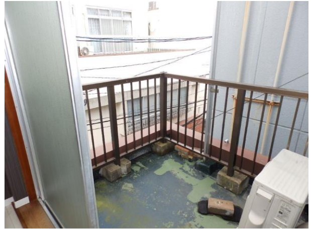
【3階 北側バルコニー】
