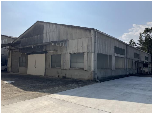
【倉庫①外観】
