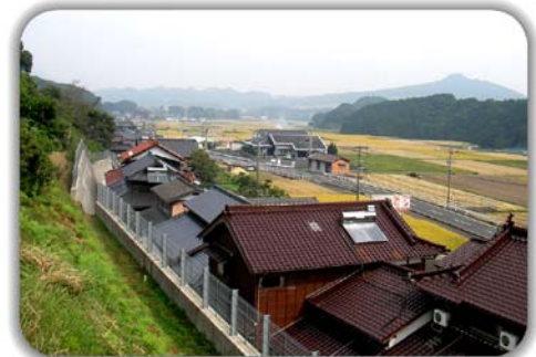
総合防災工事
