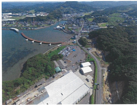
国道204号バイパスと臨港道路の状況
