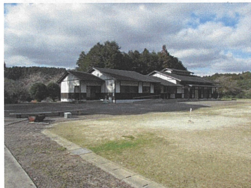
林業研修センター
