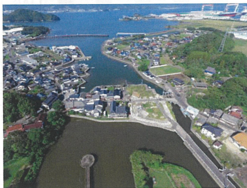
立川河川工事が進められている横土井周辺
