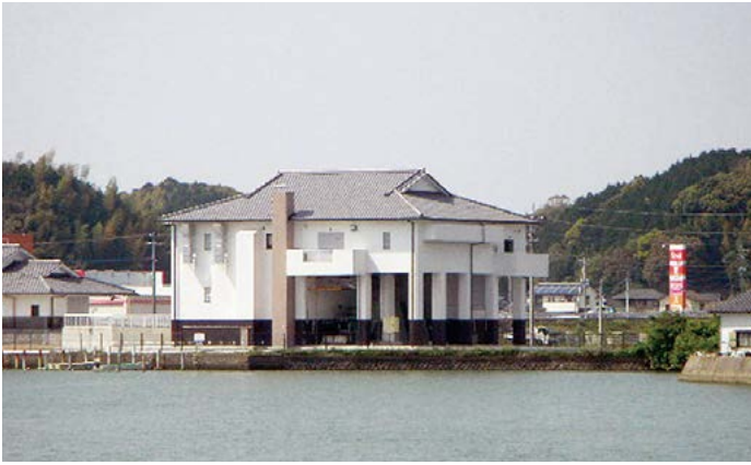
↑平成28年4月に竣工した馬伏雨水ポンプ場
