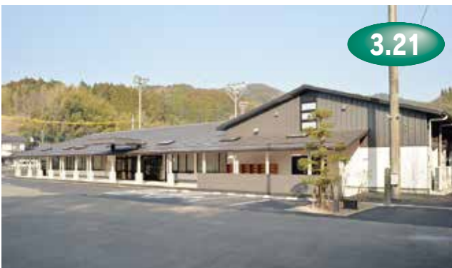
↑完成した波多津町コミュニティセンター
