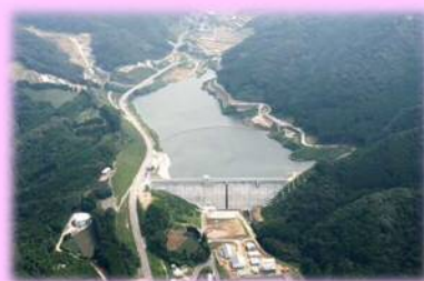
井手口川ダムと大川浄水場
