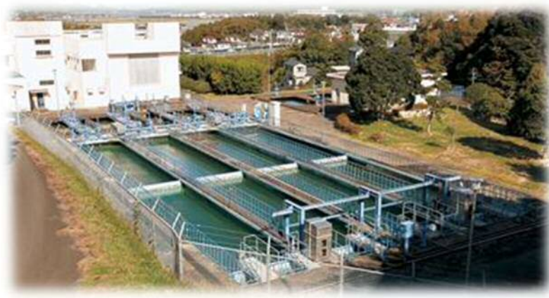
有田川浄水場
