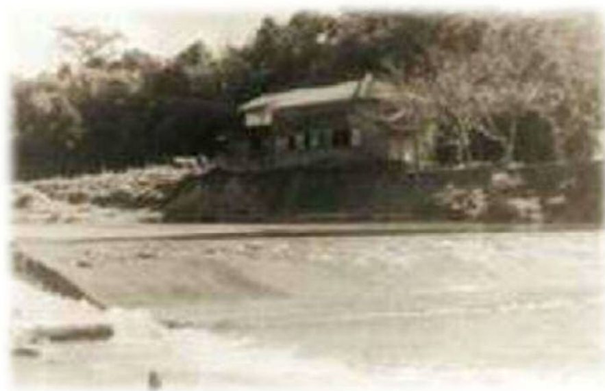
創設時の伊万里川取水口とポンプ室 （現在の円造寺公園）
