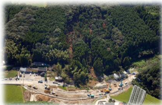
土砂災害 南波多町（H18）
