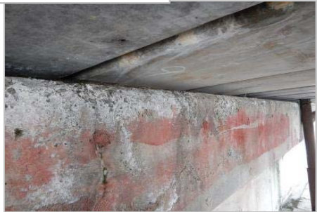
床板・下部の損傷
