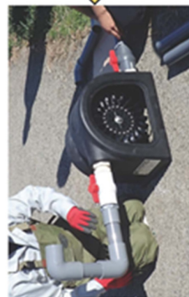
水車に入る箇所はVP管を使用 ※写真はφ50mm
