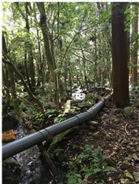
地域の人たちによる施工 (VP200mm)
