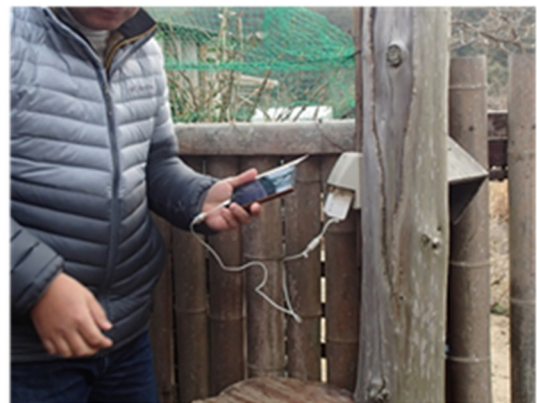
屋外用のコンセントは非常時や農機具の充電に使用
