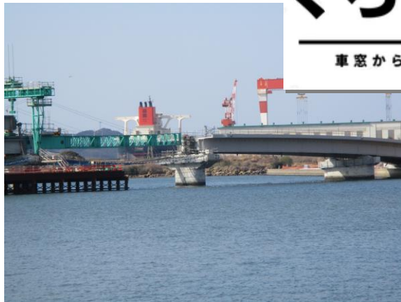
建設中の伊万里湾臨港道路道路橋梁
