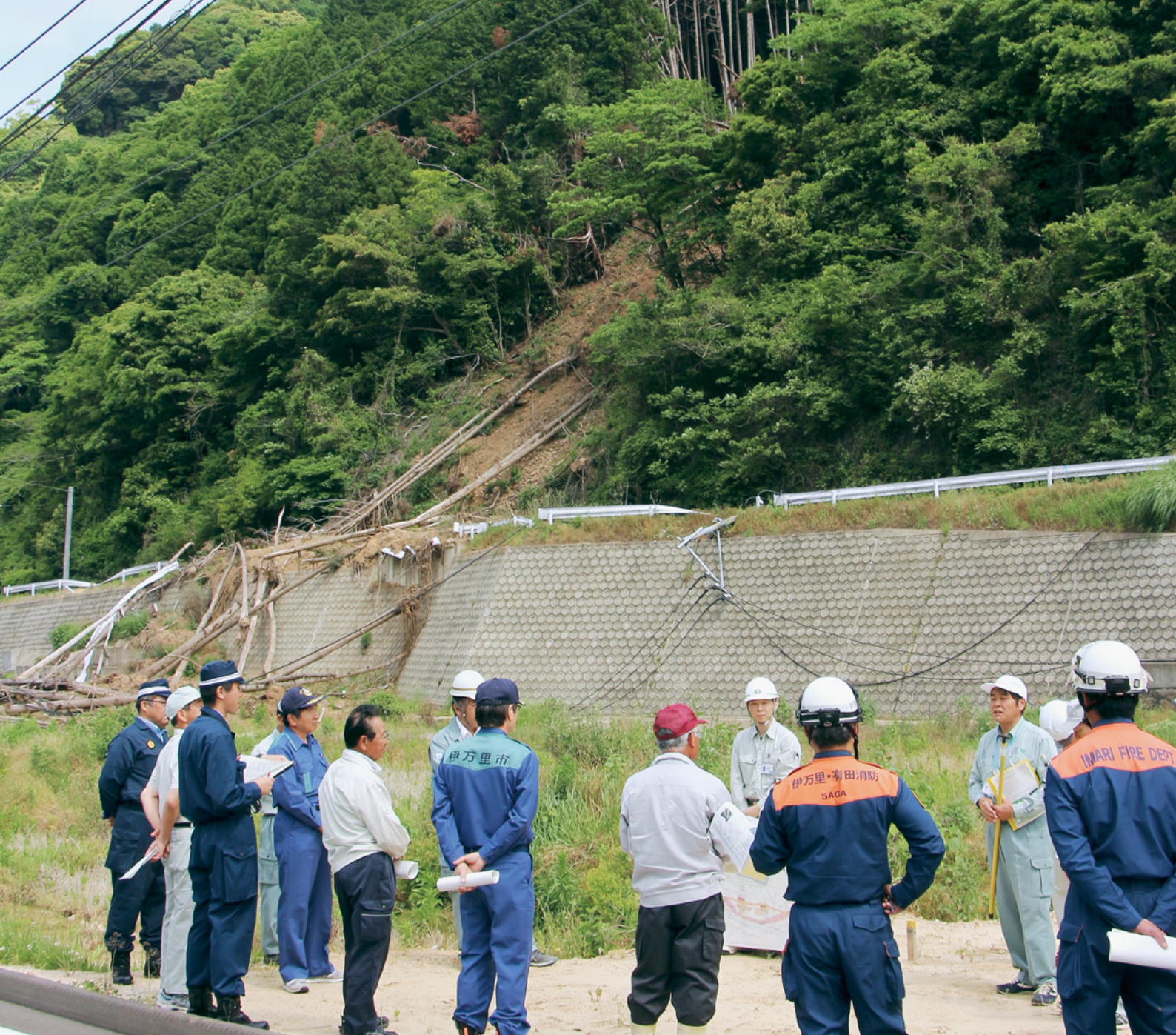
↑ 関係機関と連携し、災害箇所を確認（令和元年5月16日撮影）
