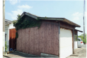
↑ 旧漁港市営住宅敷地予定地の建物 (側面)
