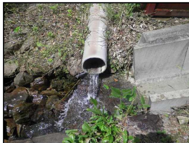
O08 : 排水タンク流出水
