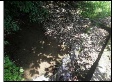
N10 : 基幹林道脇排水
