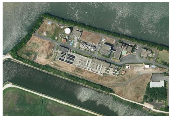
伊万里市浄化センター航空写真
