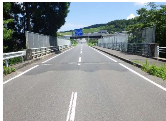
戸次郎橋舗装補修工事 (大坪町上古賀地内)
