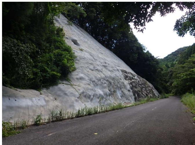
市道中山・上内野線法面補修工事（波多津町内野地内）
