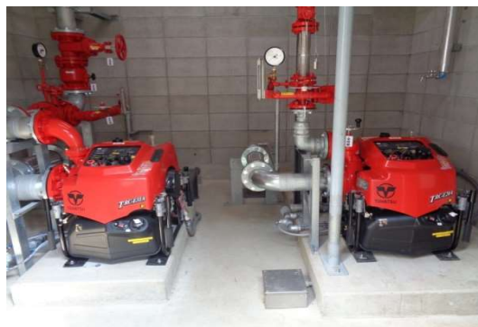
田嶋神社 ポンプ交換 着工後状況
