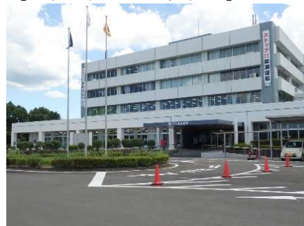
【庁舎玄関付近塗装改修】
