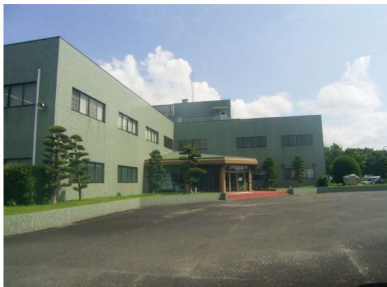
伊万里市浄化センター
