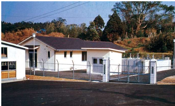
第2工業用水道浄水場
