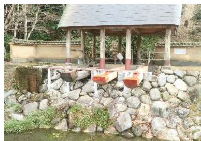
【唐臼小屋 修繕後】
