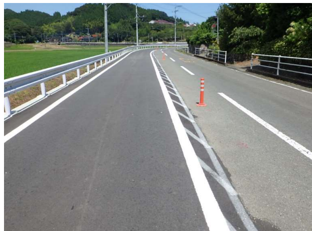
市道中山・井野尾線舗装工事（波多津町井野尾地内）
