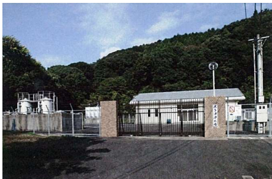
波多津浄水場
