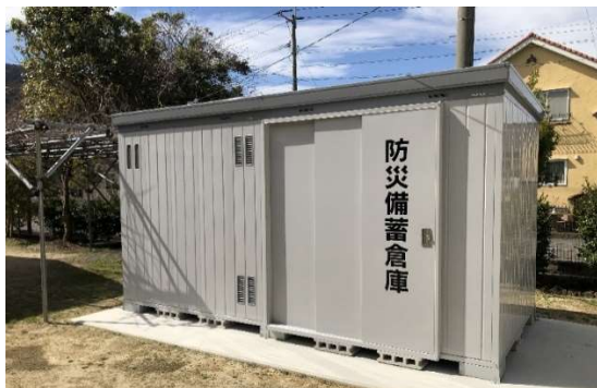
・備蓄倉庫(正面の様子)
