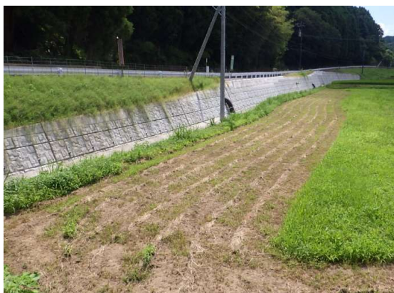
市道重橋・中山線道路改良工事 (波多津町中山地内)
