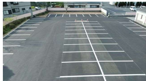
▲全面舗装後の第1駐車場
