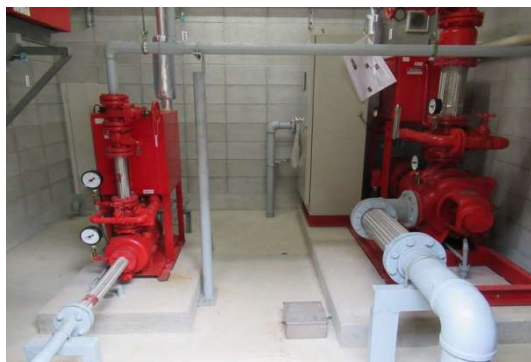
田嶋神社 ポンプ交換 着工前状況
