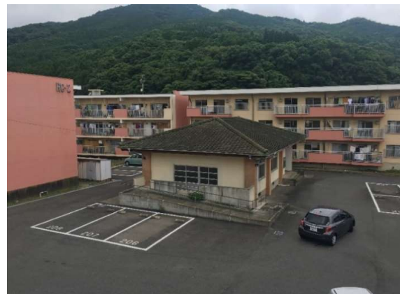
立岩市営住宅
