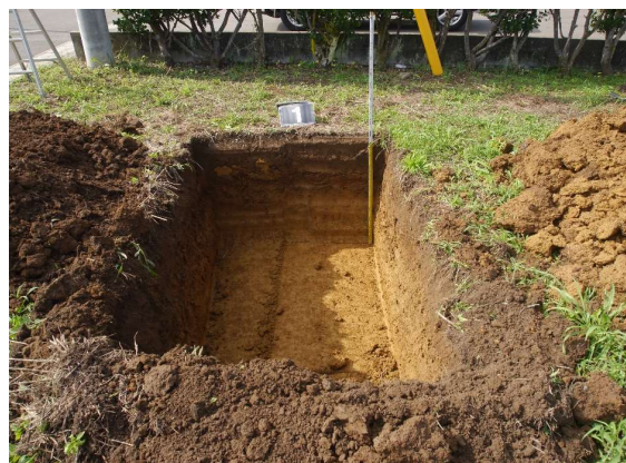
確認調査実施状況（試掘坑の状況）
