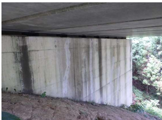
戸次郎橋橋りょう補修工事 (大坪町上古賀地内)
