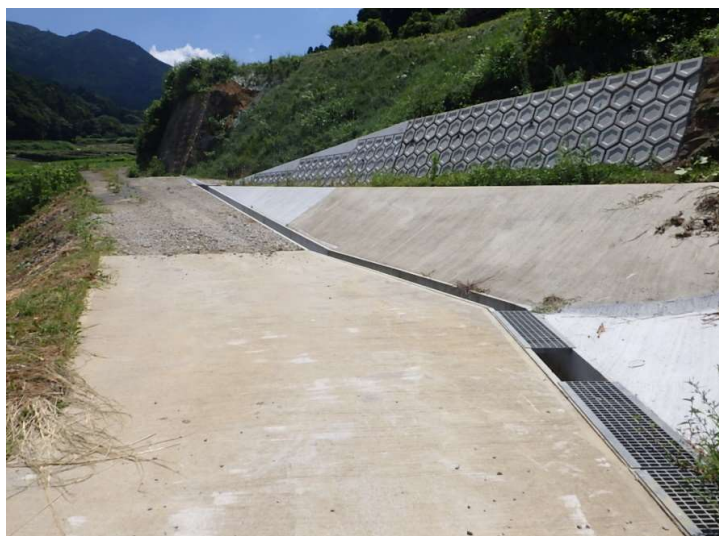
市道東田代9号線道路改良工事（大川町東田代地内）
