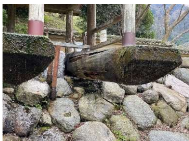
【唐臼小屋 修繕前】
