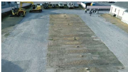
▲改装前の第1駐車場
