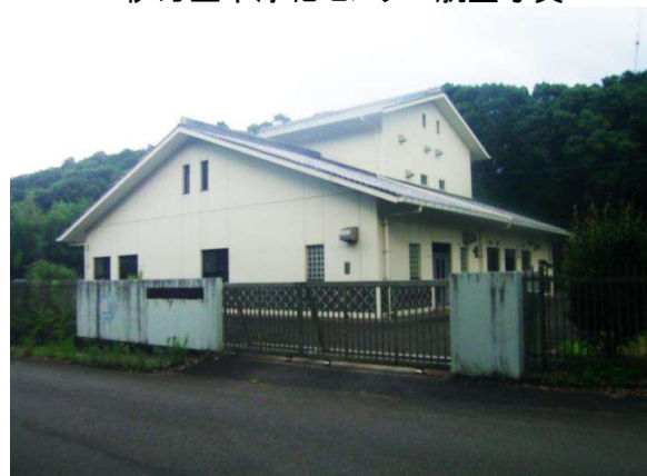
宿地区農業集落排水処理センター
