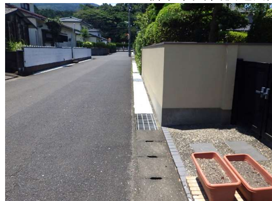
市道大里16号線外道路側溝蓋設置工事
