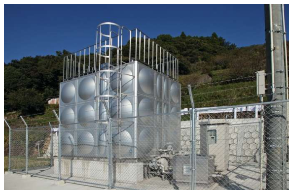
屋敷野配水池
