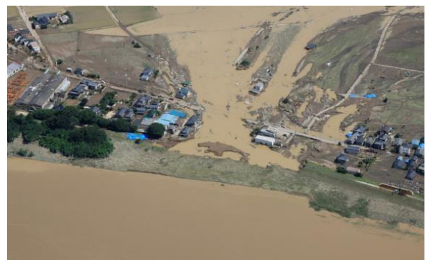
堤防決壊による家屋の流失(鬼怒川)
