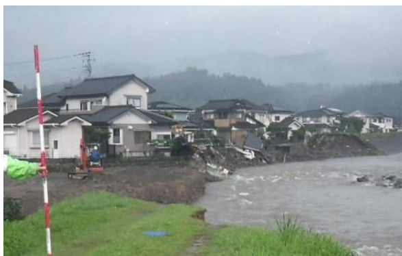
河岸侵食による家屋の倒壊(花月川)
