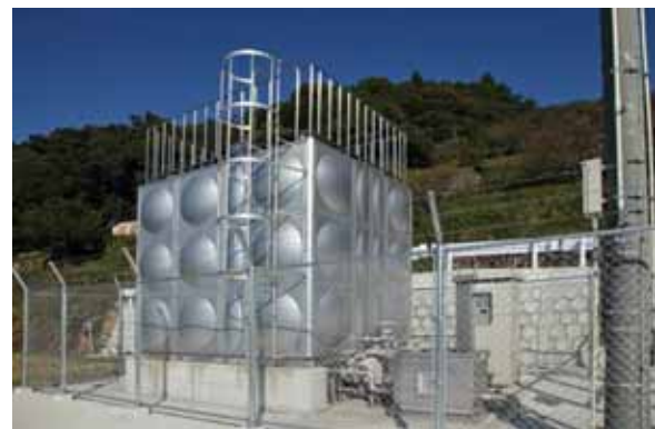
屋敷野配水池
