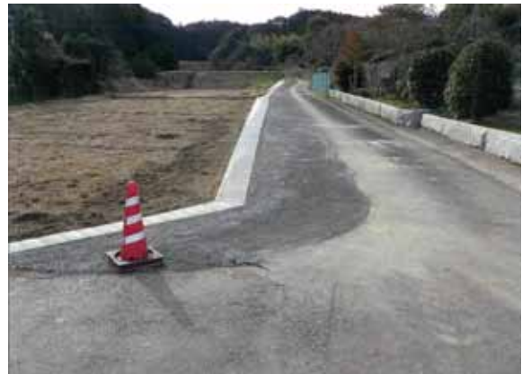
市道戸石川4号線局部改良工事（大川町戸石川地内）
