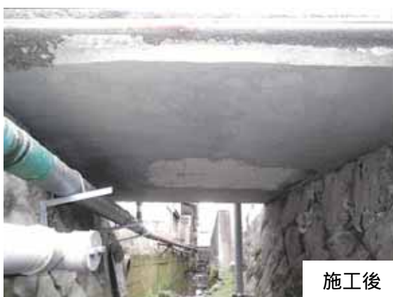
新田浜の浦2号橋補修状況 (新天町地内)
