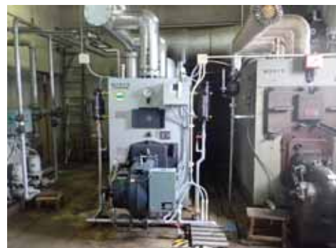
【庁舎暖房用ボイラー取替工事】
