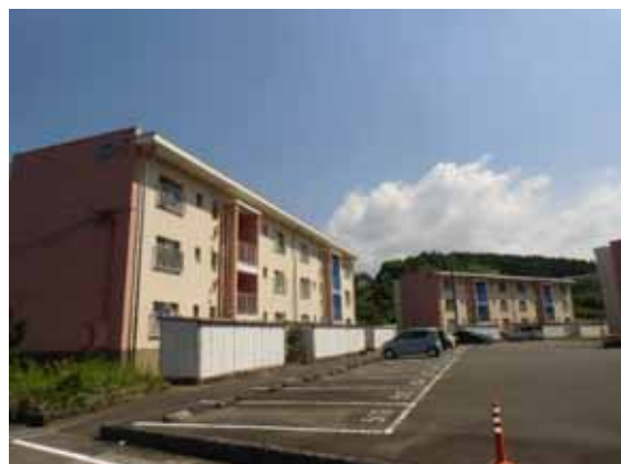
立岩市営住宅
