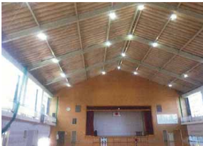
山代中学校屋内運動場天井断熱材吹付改修
