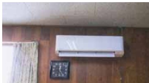
エアコンの設置
