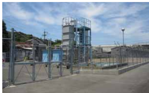
浦ノ崎浄水場
