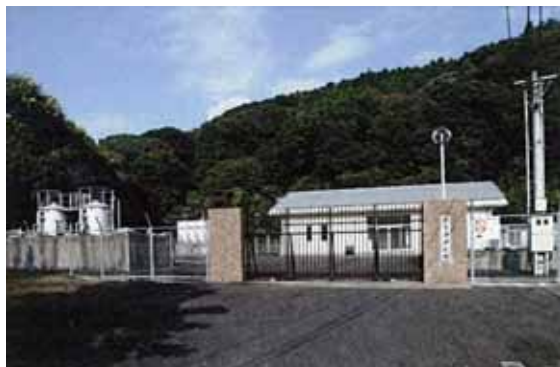
波多津浄水場
