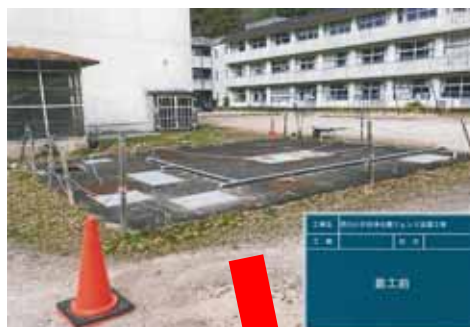
黒川小学校浄化槽フェンス設置
