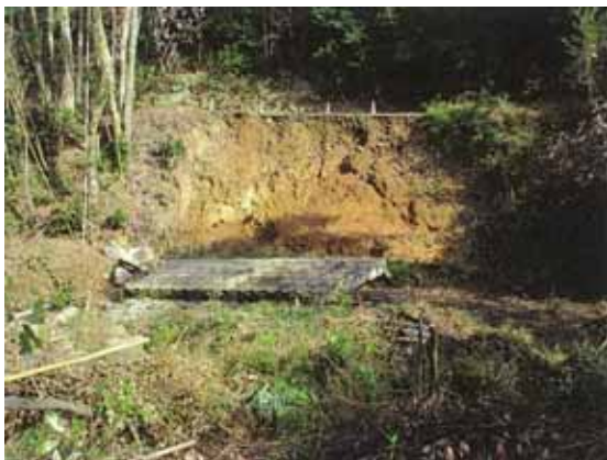
市道 笠椎・藤川内線 着工前
