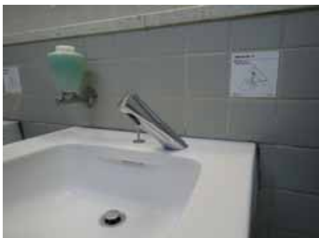
【自動水栓化工事】
