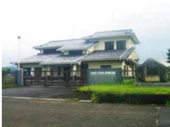
井手野水処理センター
