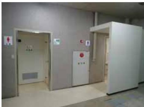
【庁舎別館トイレ等改修建築工事】
