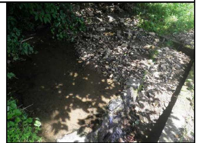
N10 : 基幹林道脇排水
