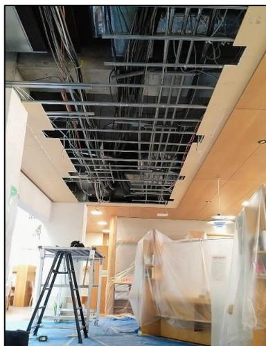
▲天井を開口して空調設備の機械を設置。
