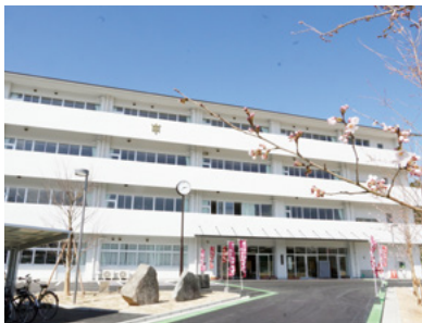
↑4階建ての伊万里中学校新校舎
