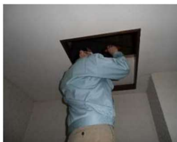
「小屋組・梁」調査の様子
