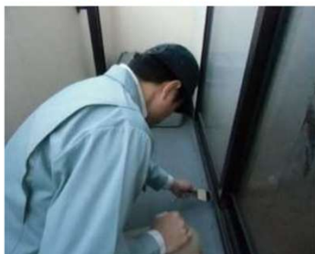
「外部（バルコニー）」調査の様子
