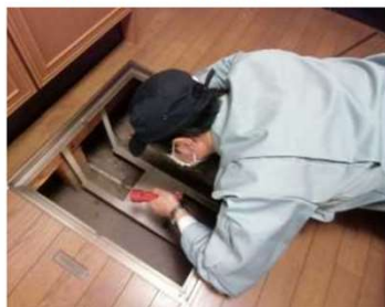
「土台・床組、基礎」調査の様子
