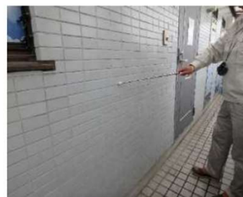
「外部（外壁）」調査の様子
