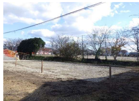
久原市営住宅解体後
