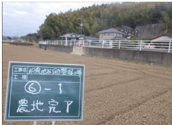
区画整理工事 完了
