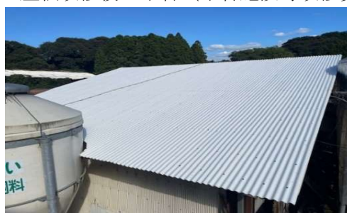
屋根改修後の牛舎（牛舎施設等改修費）
