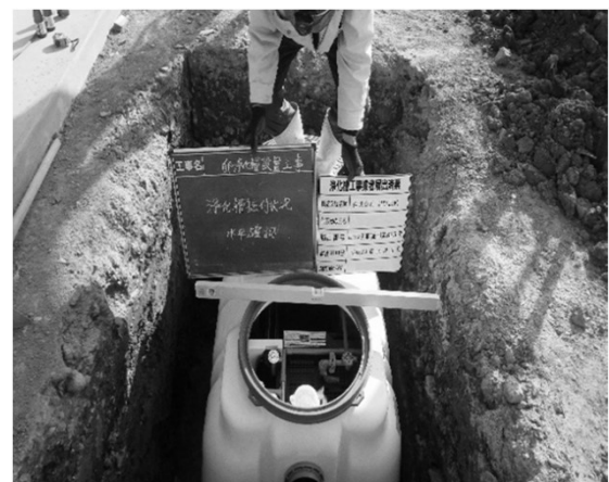
「合併処理浄化槽」設置時の確認写真 (画像引用) 市内浄化槽設備設置事業者から提供を受けたものを使用しています。
