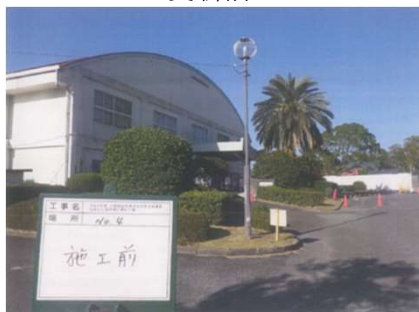
国見台公園 照明施設 更新前
