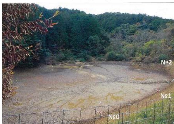
ため池浚渫 着工前
