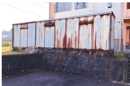
大久保市営住宅倉庫解体前
