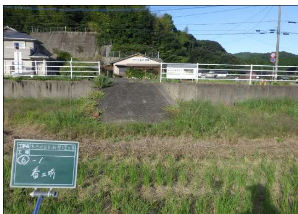
区画整理工事 着工前
