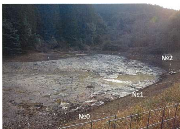
ため池浚渫 工事完了
