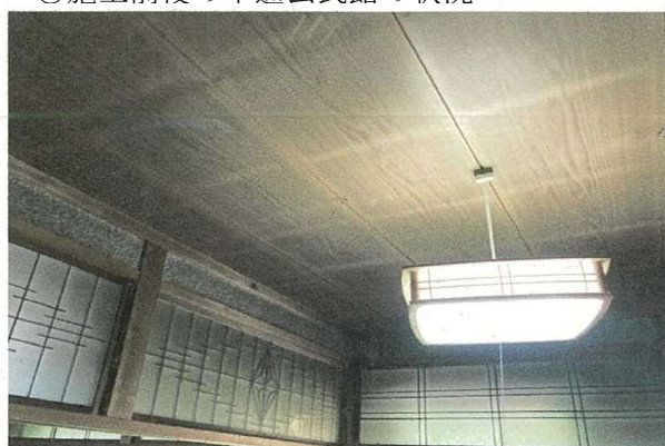
天井板取替前
