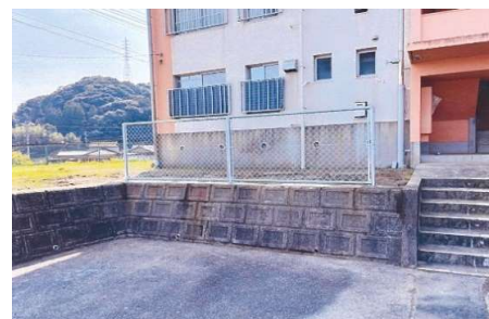
大久保市営住宅倉庫解体後
