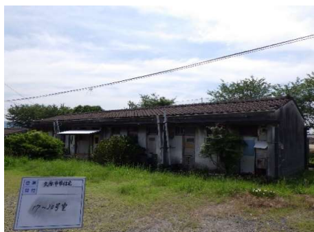
久原市営住宅解体前
