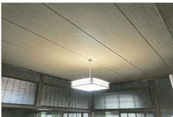
天井板取替後
