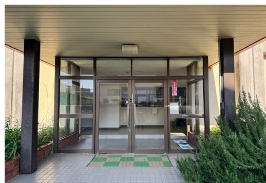
建物入口付近
