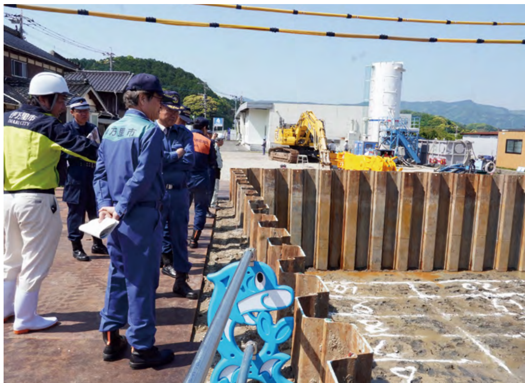
↑ 5月14日、黒川町浦分地区で行われている『浦分地区浸水対策事業』の現場で、事業内容の説明を受け、現地を確認する『防災パトロール』の参加者
