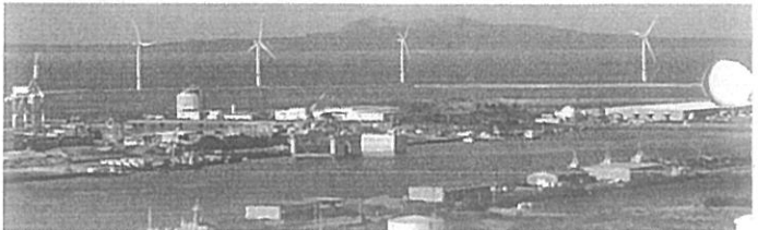
港に林立する風車は秋田港13基、能代港20基。 何れも着床式(風車の土台を海底に埋め込む方式)。
