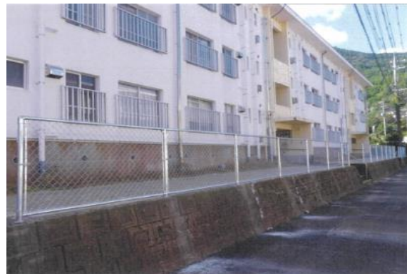
大久保市営住宅倉庫解体後
