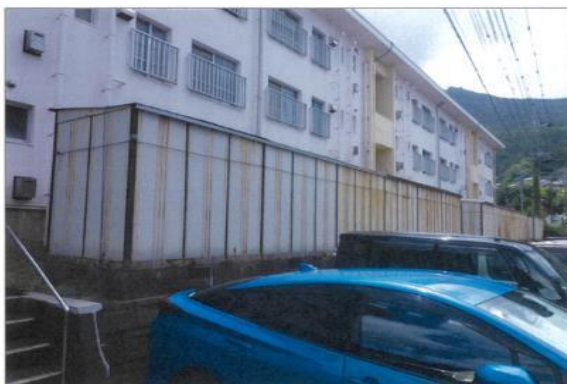
大久保市営住宅倉庫解体前
