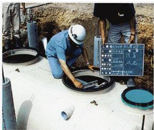
「合併処理浄化槽」設置時の確認写真 (画像引用) 市内浄化槽設備設置事業者より提供を受けたものを使用しています。
