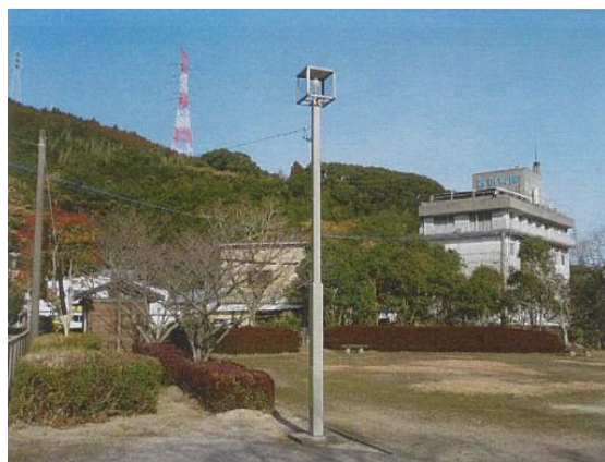
鳴石搦公園 LED照明更新 更新前
