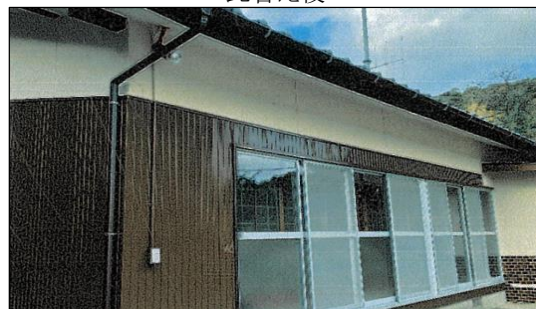
塗装改修・樋交換後
