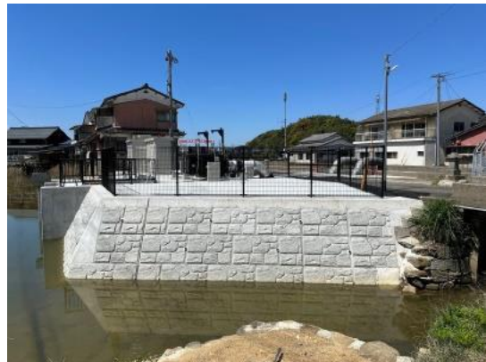
土木工事（成工）
