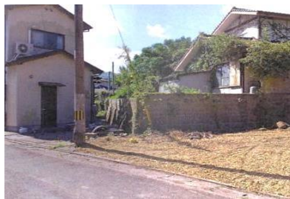
ブロック塀除去後
