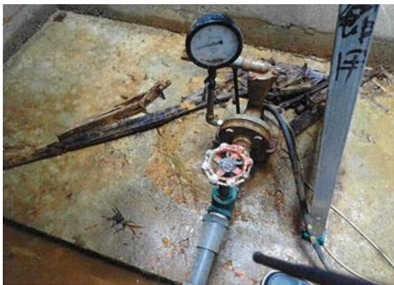
▲既設深井戸ポンプの調査
