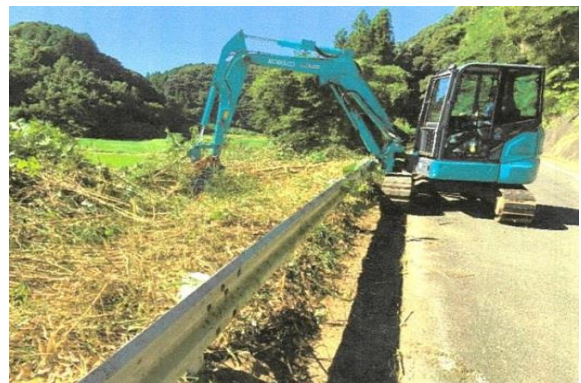
重機を使用した除草作業（波多津）
