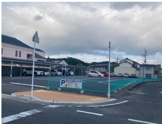
▲太陽光発電設備（カーポート型のソーラーパネル）（第2駐車場設置）
