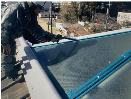
▲雨漏り補修の様子
