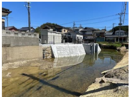
土木工事（成工）
