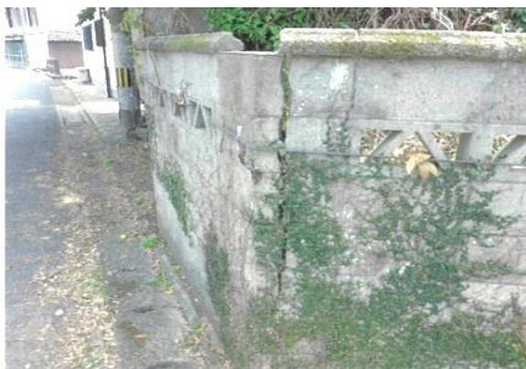
ブロック塀除去前
