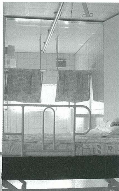
↑入浴の際、ベッドからそのまま風呂場までスムーズに移動できる『電動吊り上げ式移動機』
