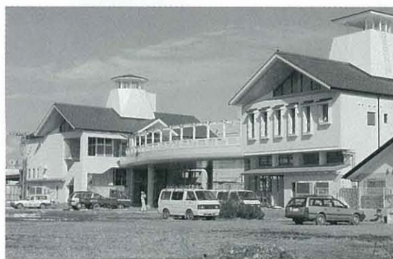
完成間近の駅ビル（南側から）
