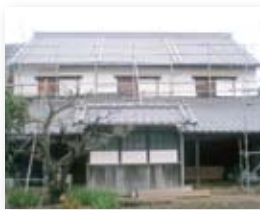
昨年行われた『前田家住宅』屋根の修理の様子
